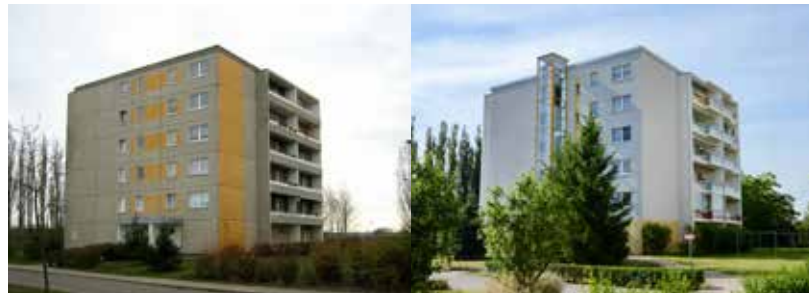
Abb. 1: Rosa-Luxemburg-Straße 55 (Würfelhaus) vor und nach der Sanierung
