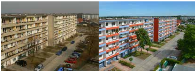
Abb. 2: Blick auf die Häuser Kniebusch 31–38 vor und nach der Sanierung
